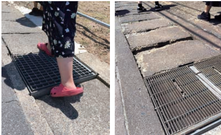
図77 エリアE・E-1コースにおける危険ゾーンの一例
