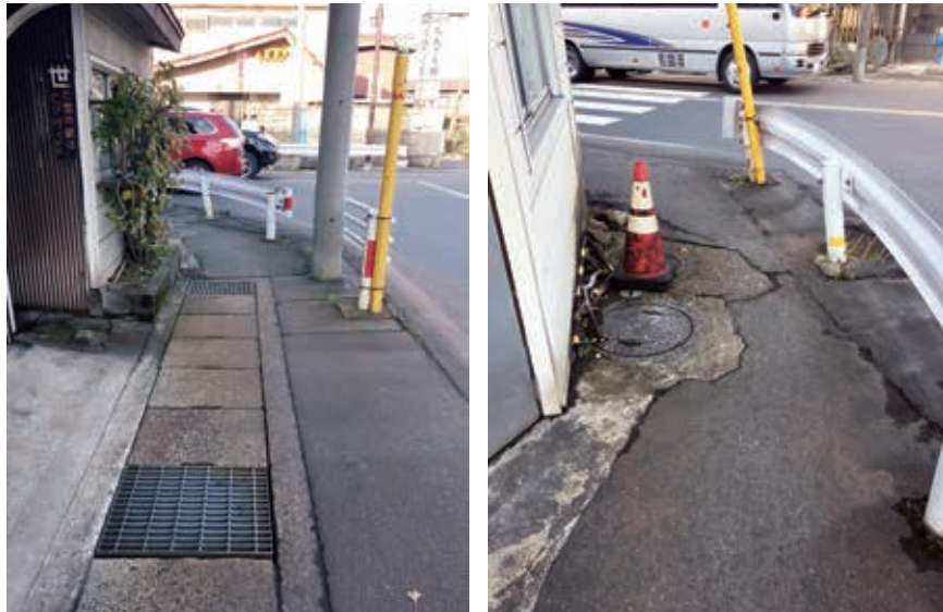
図83 エリアE・E-2コースにおける危険ゾーンの一例
