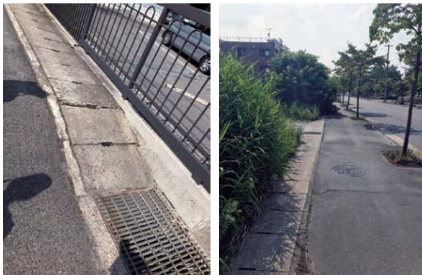
図71 エリアD・D-2コースにおける危険ゾーンの一例
