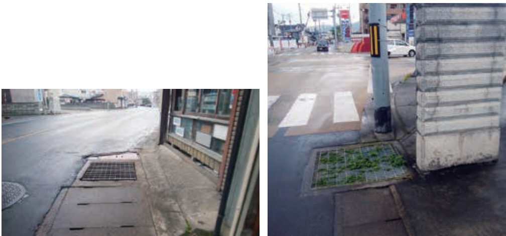
図52 エリアC・C-1コースにおける危険ゾーンの一例
