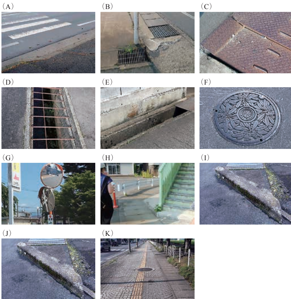
図20 調査対象物の地物 (A) スロープ (B) 金網 (C) 鉄板 (D) 排雪用側溝網 (E) 側溝 (F) マンホール (G) カーブミラー (H) ガードレール (I) セーフティパイプ (J) 縁石 (K) 点字ブロック
